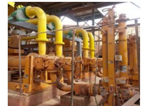
Система VPD устанавливается за поршневым насосом HSP для обработки шлама
